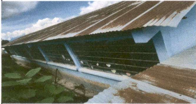
Foto1: sustitución de lámina por lámina troquelada aluzinc calibre 26
