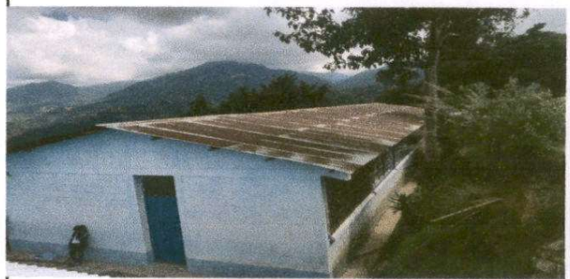
Foto 4: sustitución de canal de pvc para bajada de agua pluvial
