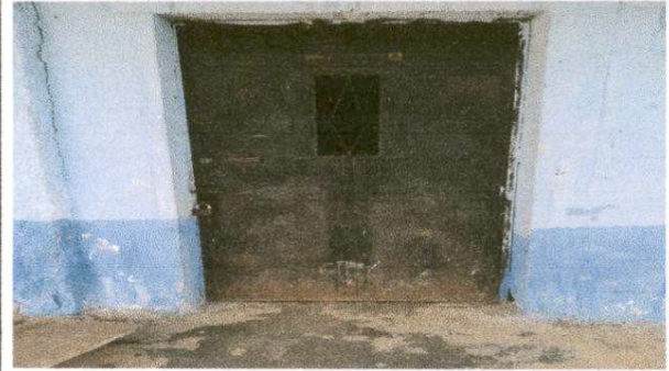
Foto 2: mantenimiento a estructura de puerta( lijado y pintura)
