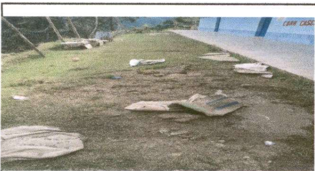
Foto 5: reparación de piso de torta de concreto
